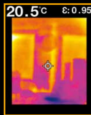
墙体发热管道
